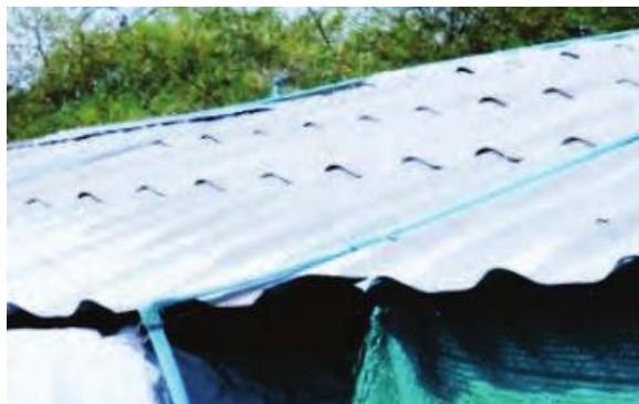
ภาพที่ 3.2 โรงเรือนสำหรับเลี้ยงหนอนนกติดตั้งสปริงเกอร์ไว้ที่หลังคาของโรงเรือนเพื่อลดความร้อน
